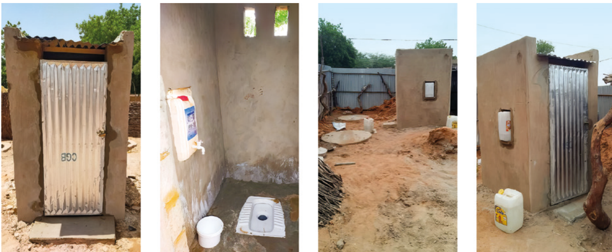
Figure 6 : Mise en place d'une latrine complète
