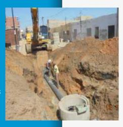
La mission de contrôle consiste au suivi des travaux suivants : Système collectif d'assainissement des eaux usées : 93 km réseaux, 7095 branchements domiciliaires, 20 SP (EU), 01 SP (EP), 02 STEP (2000 m3/j) ; Système d'assainissement Autonome : 02 STBV (60 m³/j) et 150 édicules scolaires
